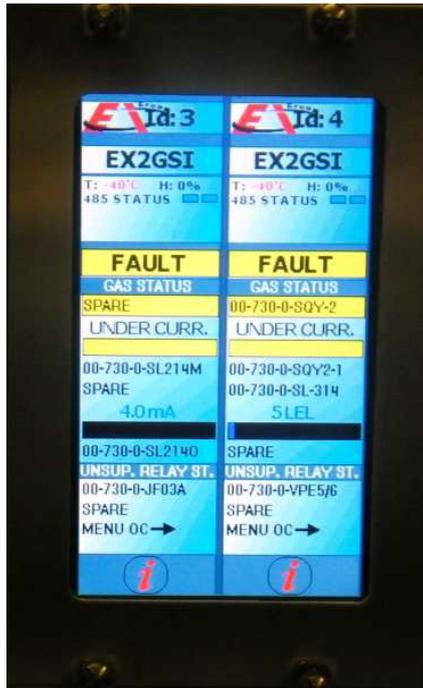
Fig. 12: scheda EX2GSI in stato di guasto per circuito di segnalazione aperto
